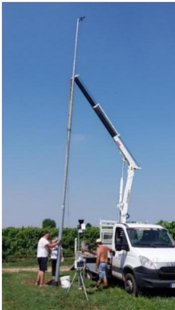
Fig. 10a Operazione di posa del palo anemometrico.
